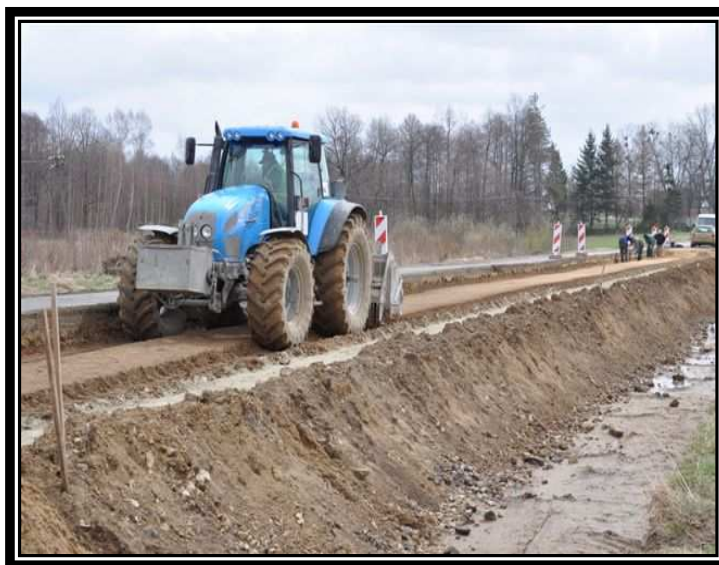
Odcinek próbny stabilizacji gruntu 1,5 MPa km 17+400.
