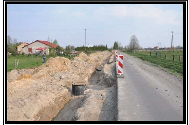
Budowa kanalizacji deszczowej Wólka Krowicka w km 12+500.
