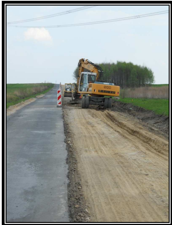
Odcinek próbny stabilizacji gruntu 1,5 MPa km 17+400.
