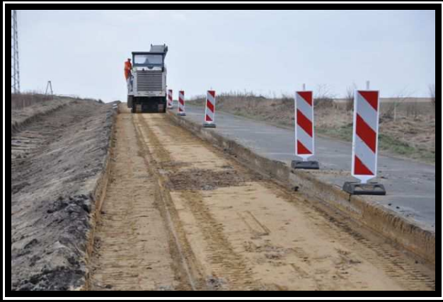
Mechaniczne rozebranie nawierzchni w km 17+300.
