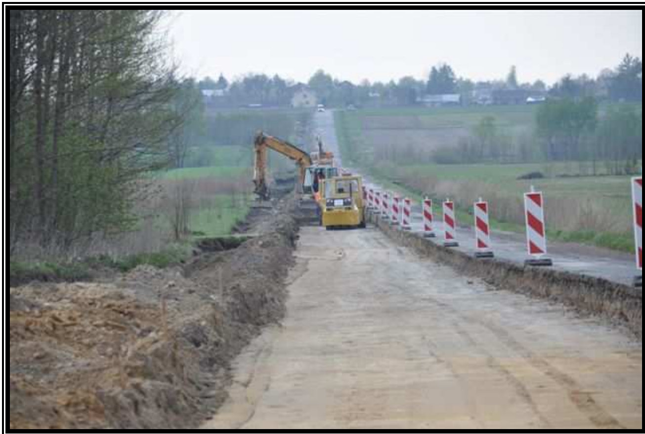
Przygotowane podłoże pod stabilizację km 14+100.
